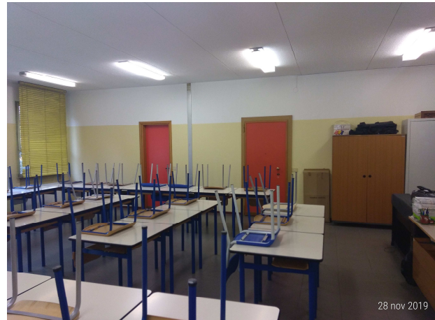
Classe tipo serramenti interni esistenti
