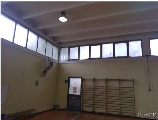
Palestra serramenti esistenti
