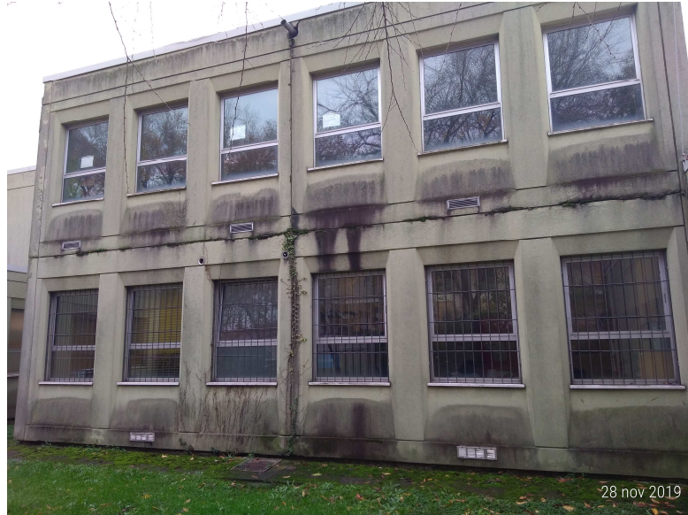
Facciata tipo scuola Secondaria di Redecesio
